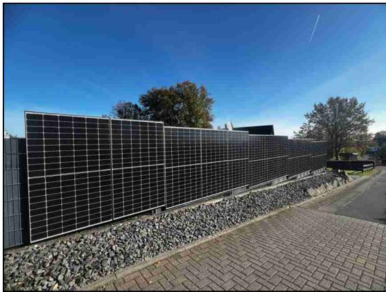
Abb. 27: Gefälleausgleich mit PV-Modulen
