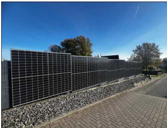
Abb. 26: Gefälleausgleich mit PV-Modulen
