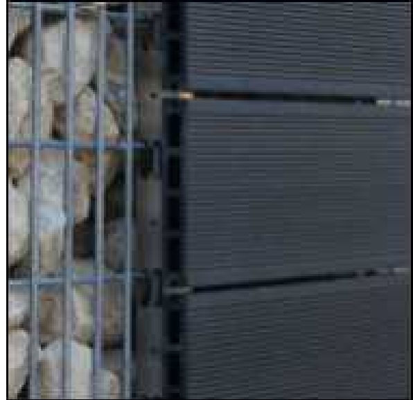
Abb. 15: Anwendung an Gabionen
