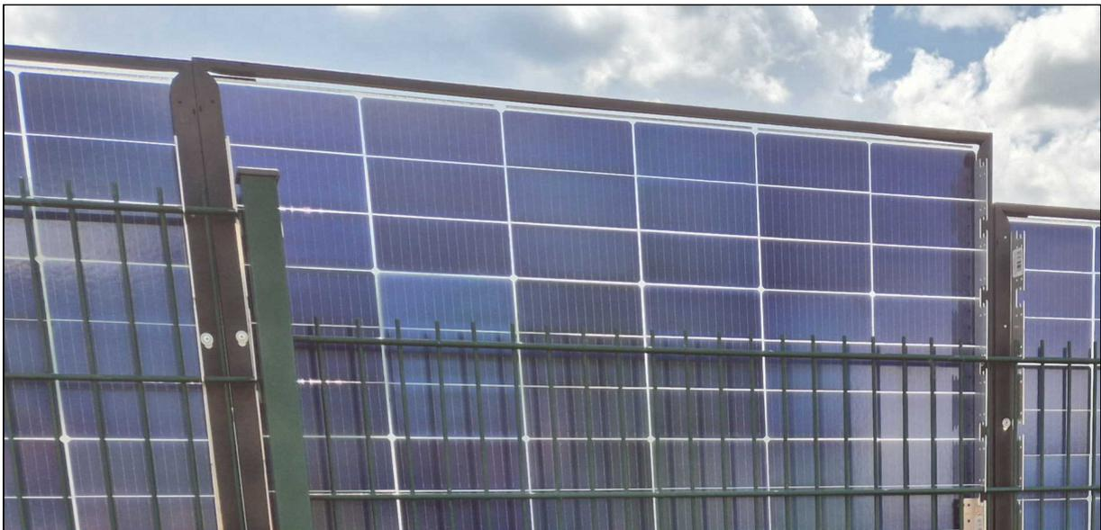
Abb. 6: Gefälleausgleich mit PV-Modulen (Zaunrückseite)
